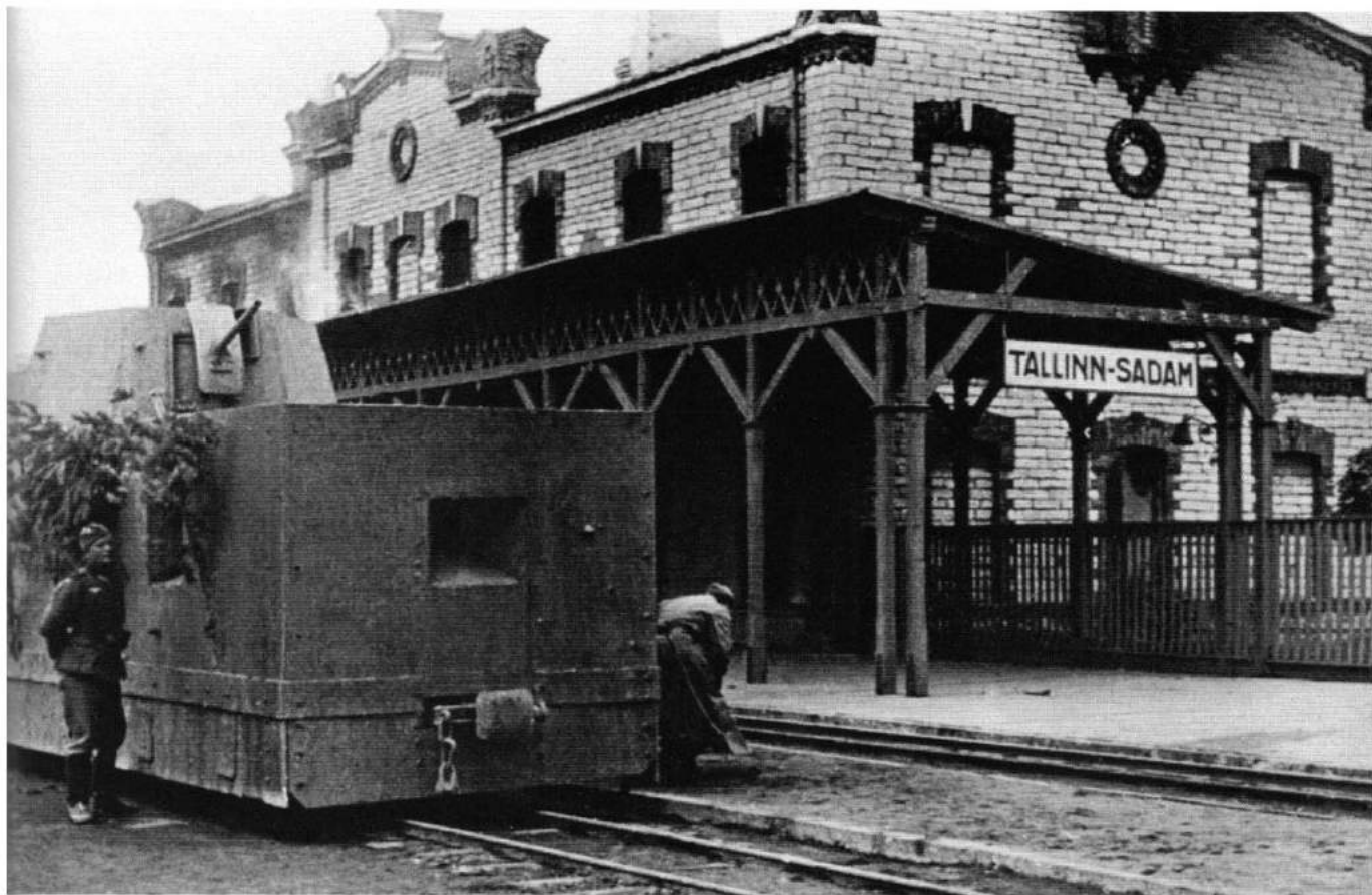
Inny porzucony sowiecki pociąg pancerny używany podczas obrony Tallina, sierpień 1941 roku. Widoczny wagon pancerny uzbrojony w armatę B-3 kalibru 37 mm. Another abandoned Soviet armoured train used during defence of Tallin in August 1941. Note armoured wagon armed with an 37mm calibre B-3 gun. [CAW]
