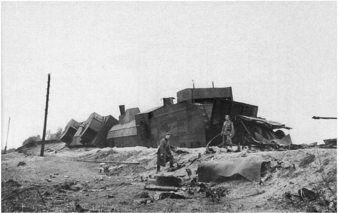
Porzucony, uszkodzony pociąg pancerny „Marszałek Budionny”, wrzesień 1941 roku. Widoczny parowóz ze stanowiskiem przeciwlotniczego karabinu maszynowego i całkowicie zniszczony w wyniku wewnętrznej eksplozji tylny wagon pancerny. An abandoned, damaged „Marschal Budyonny” armoured train, September 1941. Note a locomotive with AA machine gun position and in the foreground a destroyed by internal explosion rear armoured wagon. [J. Magnuski]
