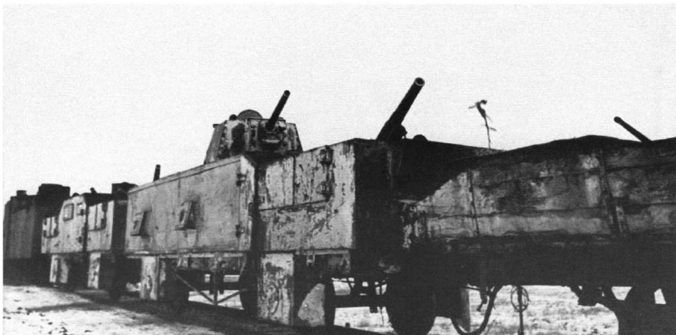
Wagon pancerny pociągu pancernego „Mściciel Ludu” z 71. Samodzielnego Dywizjonu Pociągów Pancernych uzbrojony armatę przeciwlotniczą Lender wzór 1914/1915 kalibru 76,2 mm i wieżę czołgu KW-1 z armatą ZIS-5, zima 1943 roku. An armoured wagon of the armoured train “Avenger of Nation” from the 71st Independent Armoured Train Battalion armed with an 76.2mm calibre Lender Model 1914/1915 AA gun and a KV-1 tank turret armed with ZIS-5 gun, Winter 1943. [ASKM]
