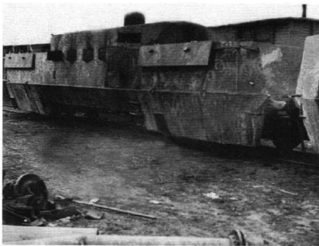
Nieuzbrojony wagon pancerny jednego z pociągów pancernych używanych na Krymie. An unarmed armoured wagon of the armoured train used on Crimea. [J. Magnuski]
