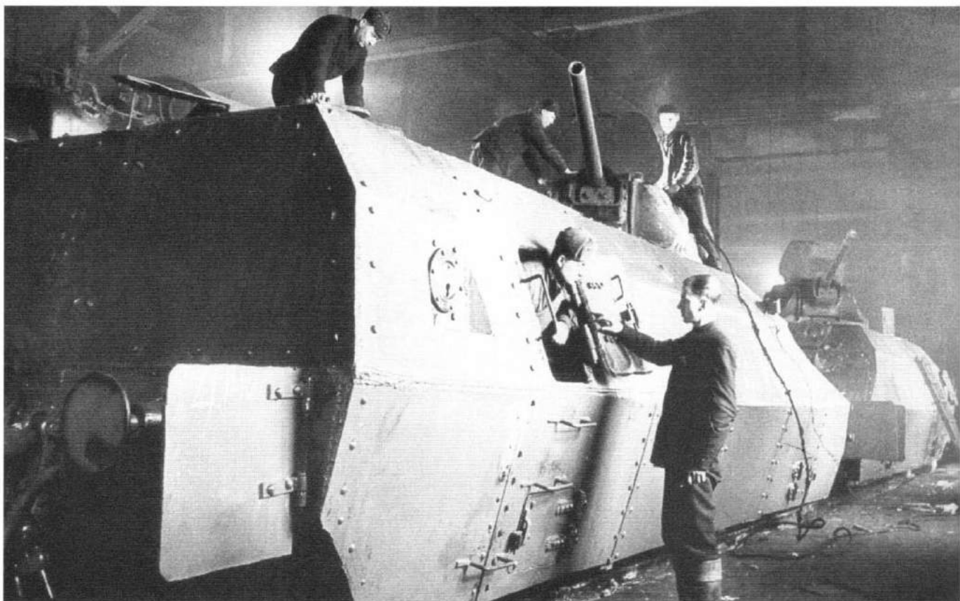
Montaż wagonu pancernego pociągu pancernego nr 1 „Śmierć Niemieckim Okupantom!” z 48. Samodzielnego Dywizjonu Pociągów Pancernych w warsztatach w Lichoborach. The assembly of an armoured wagon of an armoured train No. 1 nicknamed "Death of German Occupants!" from the 48th Independent Armoured Train Battalion at works in Lichobory. [ASKM]
