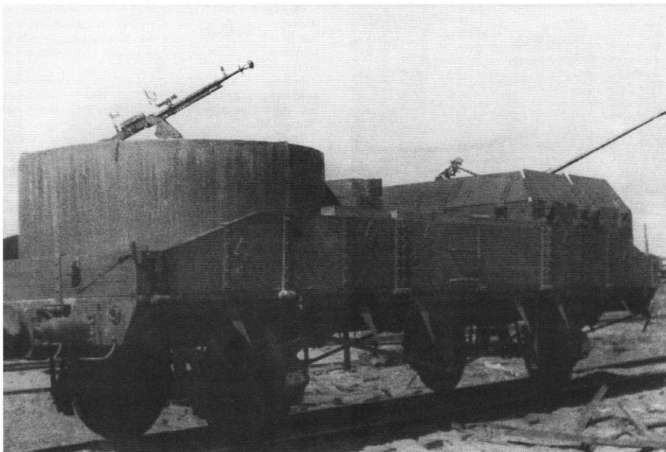
Wagon pancerny obrony przeciwlotniczej produkcji zakładów „Stalmost” z pociągu pancernego nr 1 z 32. Samodzielnego Dywizjonu Pociągów Pancernych uzbrojony w działko kalibru 25 mm i karabin maszynowy DSzK. An AA defence armoured wagon manufactured at “Stalmost” Plant of an armoured train No. 1 from the 32nd Independent Armoured Train Battalion armed with an 25mm AA gun and DSzK machine gun. [ASKM]
