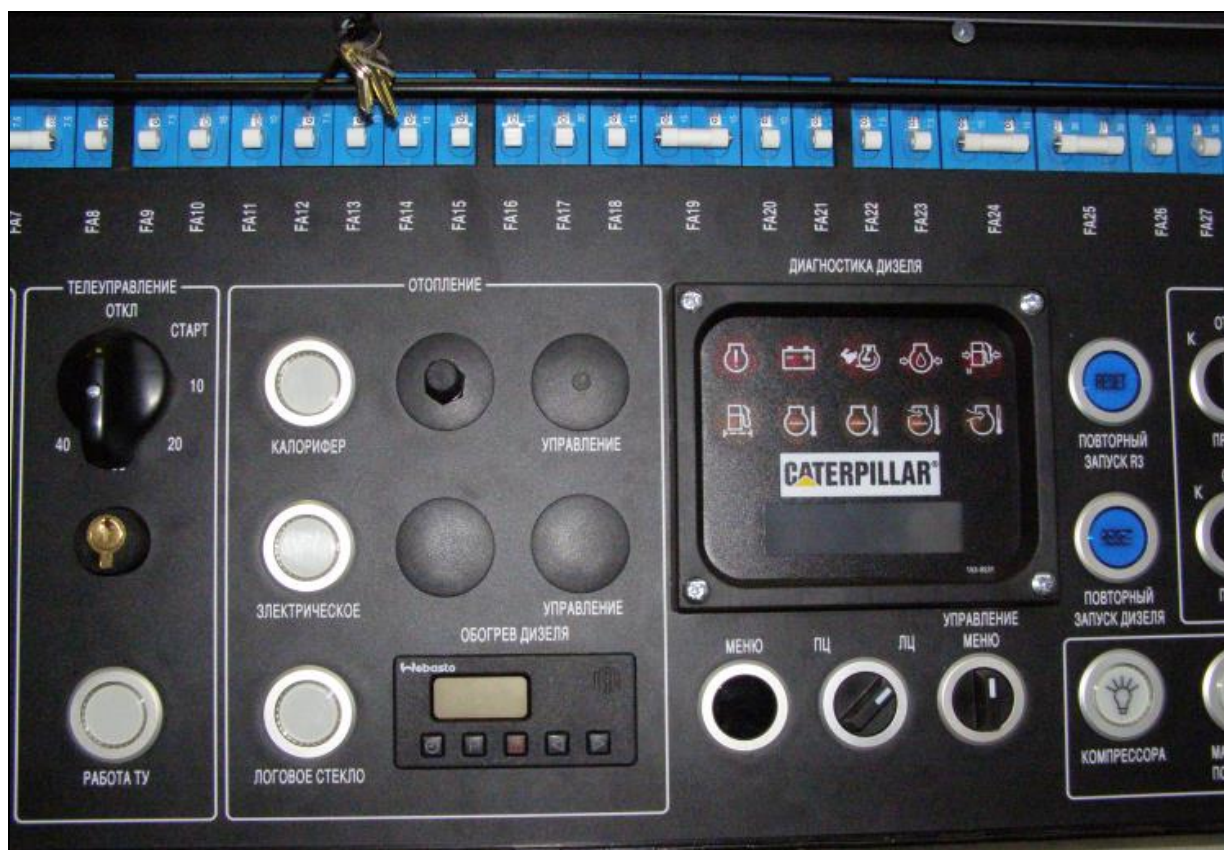
рис. 48: Средняя часть панели электрораспределителя R2
