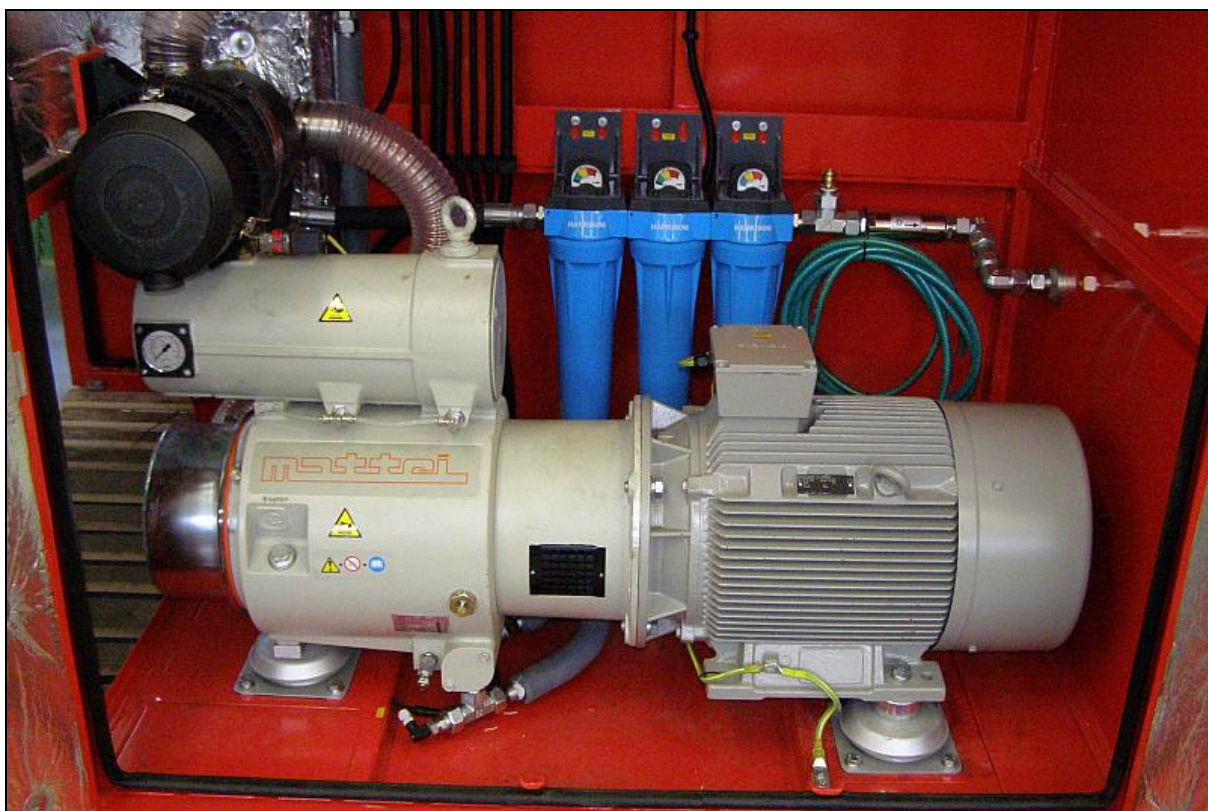
рис. 7: Компрессор пластинчатый Mattei M 111 H
