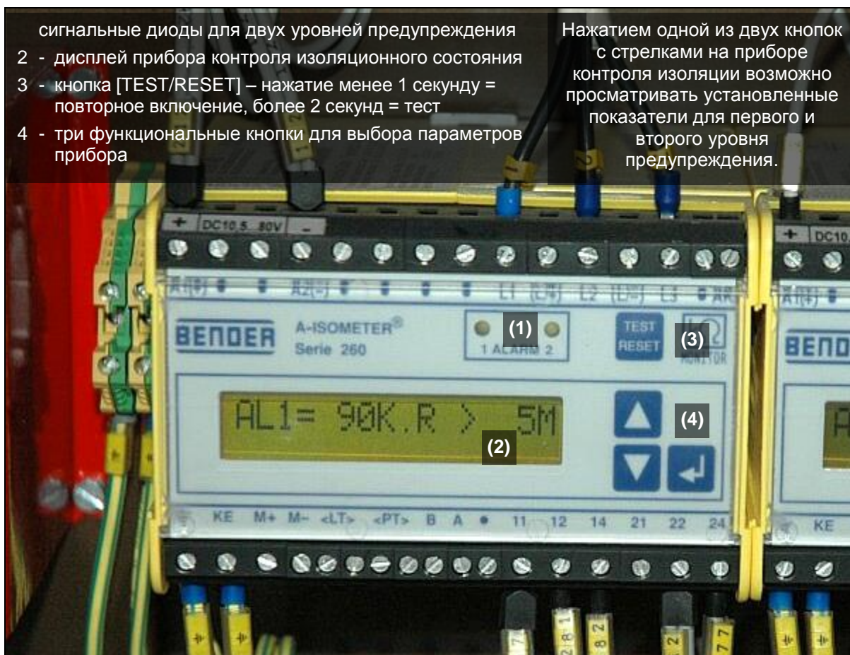
рис. 23: Прибор контроля изоляционного состояния (BENDER)
