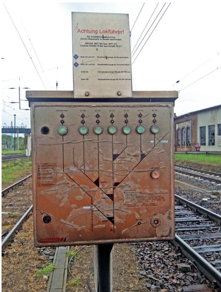
Eine Schalttafel zur Bedienung durch den Lok-Rangierführer in der Einfahrt zur Lokabstellgruppe im Rail und Logistik-Center Wustermark. Die EOW-Anlage wurde dort schon zu DB-Netz-Zeiten eingebaut.
