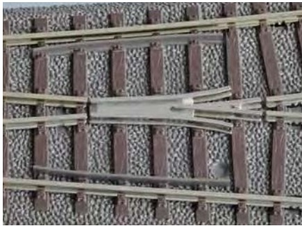
Das Herzstück einer H0-Trix-C-Gleis-Weiche ist für „langsame“ Züge zu polarisieren.
