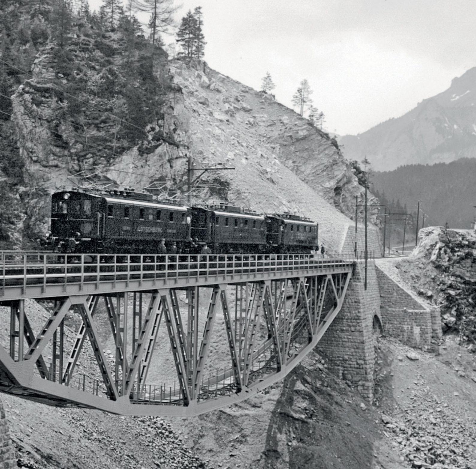
GROSSES FOTO: Im Mai 1913 wurde die Sarengraben-Brücke den Lastproben unterzogen. Dies übernahmen drei Elloks Fb 5/7 mit 321 t Gesamtgewicht.
