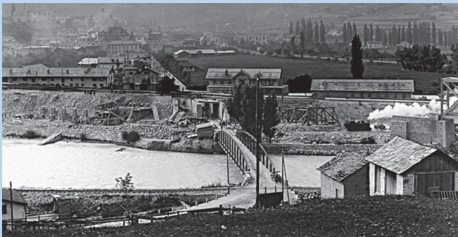
Dienstbahn am Rhoneufer (1912): An den Fundamenten des Briger BLS-Depots wird gearbeitet.
