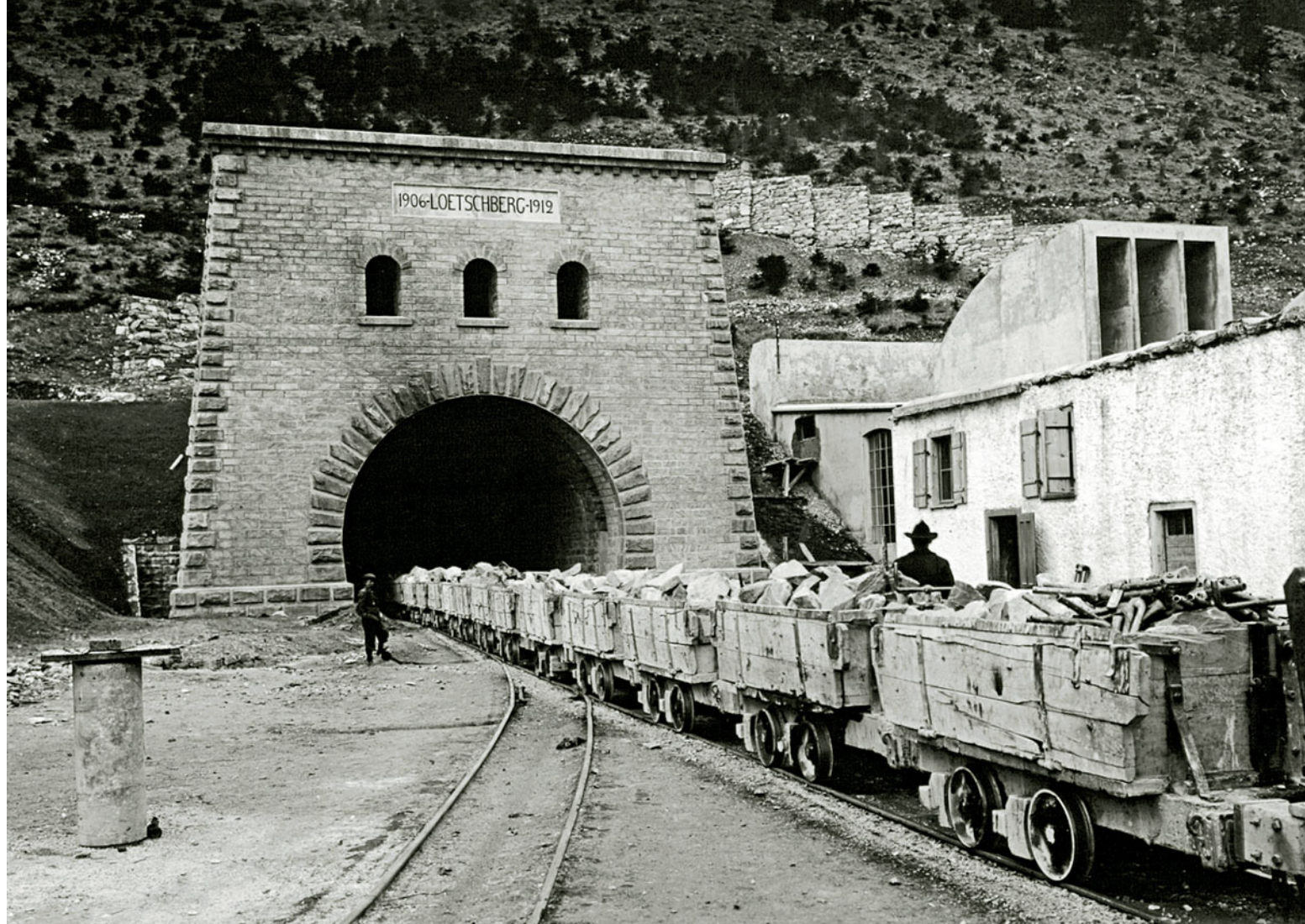
Ausfahrt eines Stollenzuges mit Ausbruchmaterial und abgenutzten Bohrwerkzeugen beim Nordportal des Scheiteltunnels in Kandersteg (20. Juni 1912).
