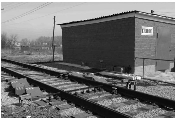
Рис. 14.5. Общий вид поста КТСМ и напольных камер
