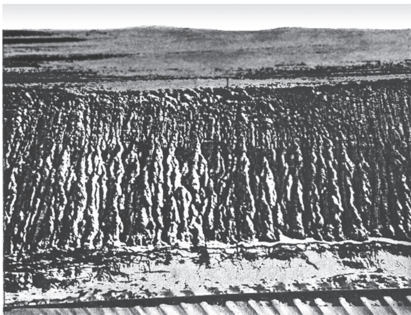
Рис. 4.20. Водно-эрозионное разрушение поверхности откоса насыпи дождевыми осадками
