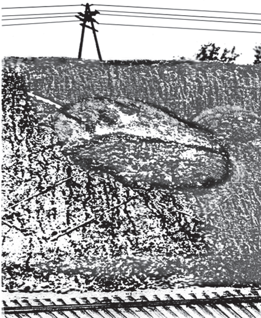
Рис. 4.19. Поверхностный спływ (смещение) откоса выемки в глинистых грунтах
