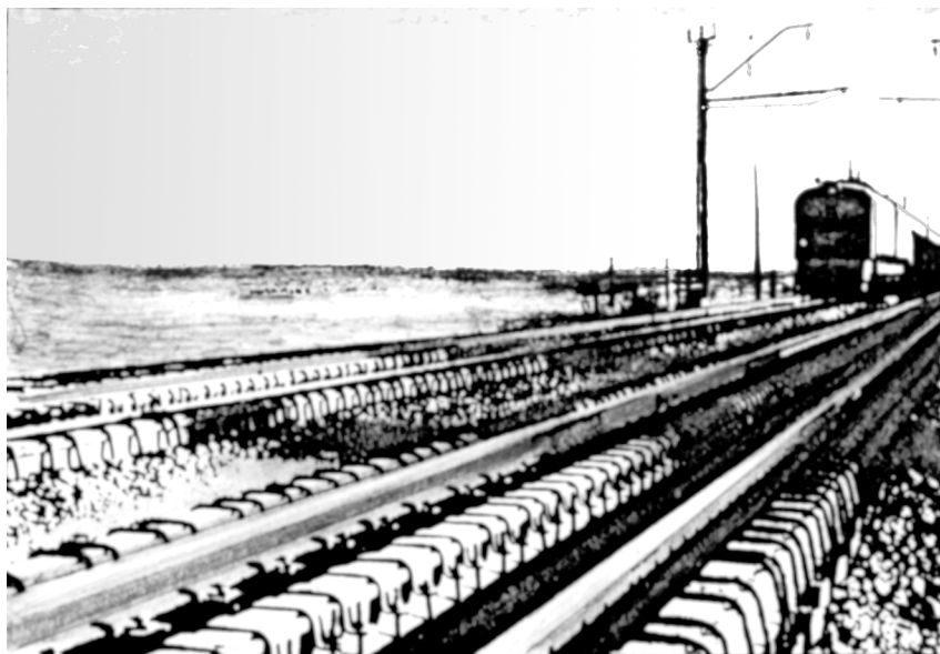
Рис. 4.71. Усиление рельсошпальной решетки на карстовых участках рельсовыми пакетами
