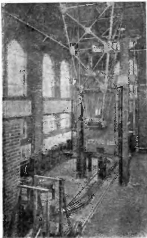
Фиг. 65. Автоматическая ударная машина АРА в университете Пардью для испытания поглощающих аппаратов.
