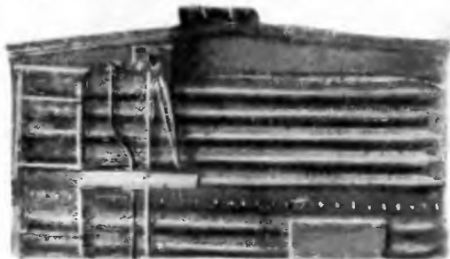
Фиг. 264. Ручной тормоз с откидным рычагом и храповиком. Виден задерживающий край.
