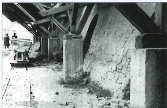
Strzelce Opolskie. Wywrotki (koleby) o poj. 0,75 m 3 pozostawione pod jednym z pieców do wypału wapna typu Hoffmana, po zaprzestaniu pracy tych pieców. Lata 80. XX w.
